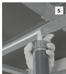
Figura 8: boquilla con sección en forma de V.
