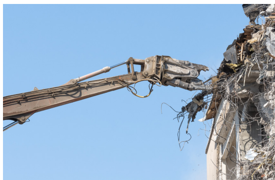
Imagen izquierda: Desmontaje selectivo
