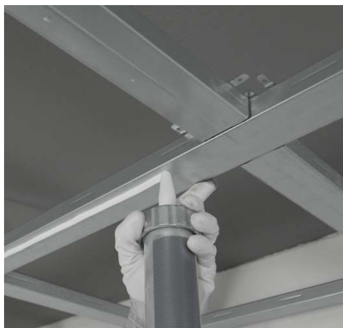
Aplicación de adhesivo con pistola de batería
