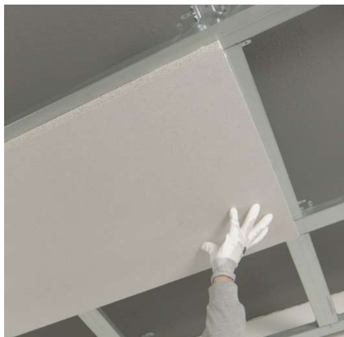
Instalación del panel acústico presionando
