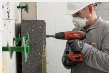
3. Desmontaje de aislamiento
