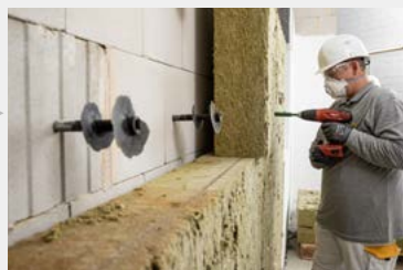
3. Desmontaje de aislamiento
