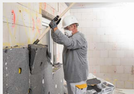
B. Sistemas encolados y fijados con tacos 3. Desmontaje de aislamiento
