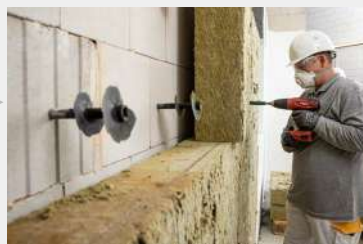
3. Desmontaje de aislamiento
