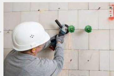
4. Desmontaje de la fijación
