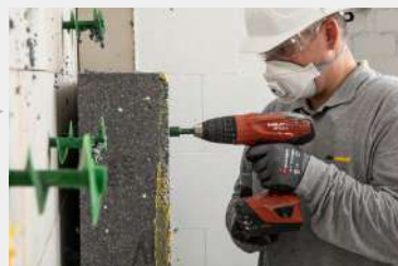
3. Desmontaje de aislamiento
