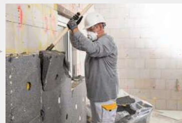
4. Desmontaje de aislamiento
