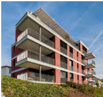
Vivienda multifamiliar, Überlandstrasse, Dübendorf, CH
