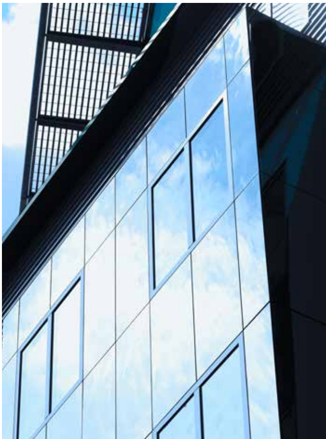
Fachadas de vidrio con espejo. Hospital clínico, Hoyerswerda, Alemania, oficina de arquitectura: top consult köln GmbH, Colonia, Alemania
