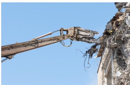
Imagen izquierda: Desmontaje selectivo
