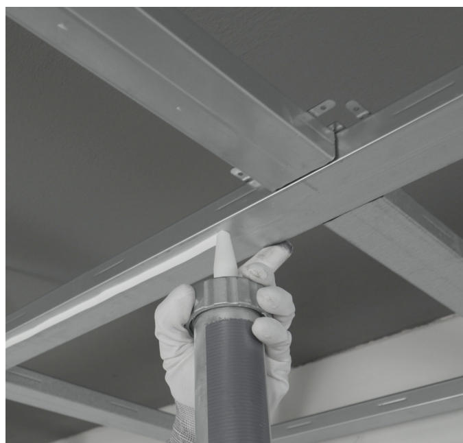
Aplicación de adhesivo con pistola de batería
