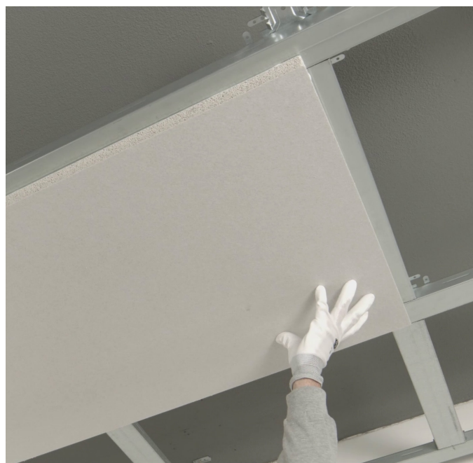
Instalación del panel acústico presionando
