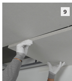
Figura 11: montaje de paneles en el área de los bordes y juntas planas
