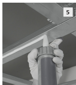
Figura 8: boquilla con sección en forma de V.
